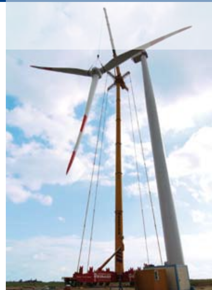
Zwei Riesen ragen in den Himmel – ein Manitowoc-Kran im Einsatz bei der Montage eines Windrades.
